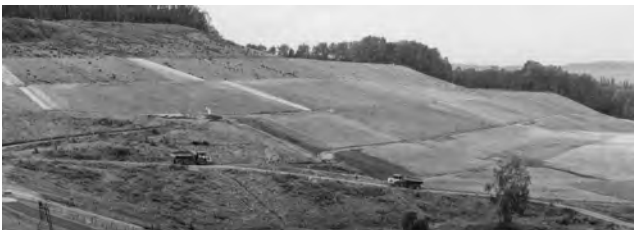
Die Waldhalde im Norden der IAA Culmitzsch hat eine neue Kontur. An der Nordspitze, rechts im Bild, wird die Abdeckung aufgebracht.
