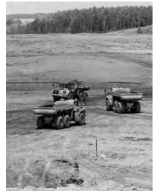
Materialeinbau im Becken B der IAA
