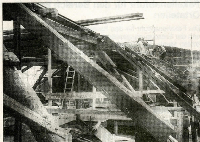
Der alte Dachstuhl wird abgebrochen.
