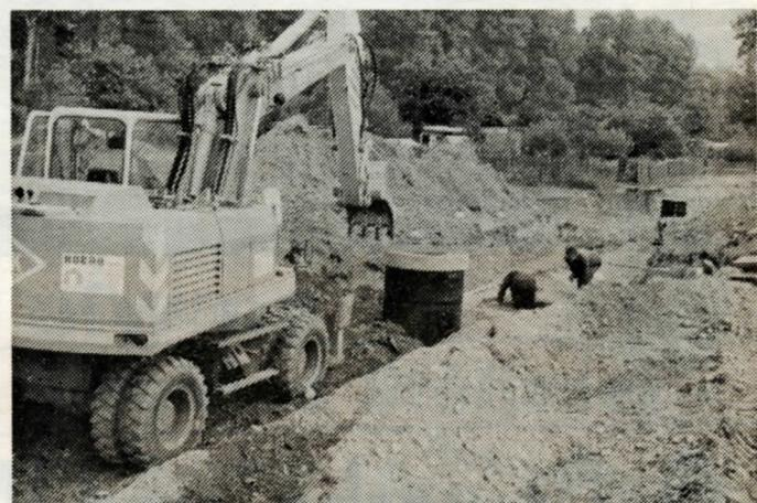
Zum Stand der Bauarbeiten im Gewerbegebiet muß festgestellt werden, daß im Bereich des Gewerbegebietes die Verlegung der Trinkwasserleitung, des Schutzwassers sowie des Oberflächenwasserkanals einschließlich der Bau aller Sammler und der Zuführung zur Elster abgeschlossen ist.
