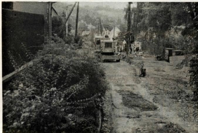
Die Arbeiten für die Verlegung der Trinkwasserleitung in der Ernst-Thälmann-Straße gehen zügig voran. Nachdem zuerst der gesamte Graben ausgeschachtet wurde, konnte eine speziell ausgebildete Gruppe die Trinkwasserleitung dort verlegen.
